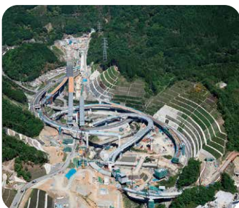
新名神高速道路 北山川橋
